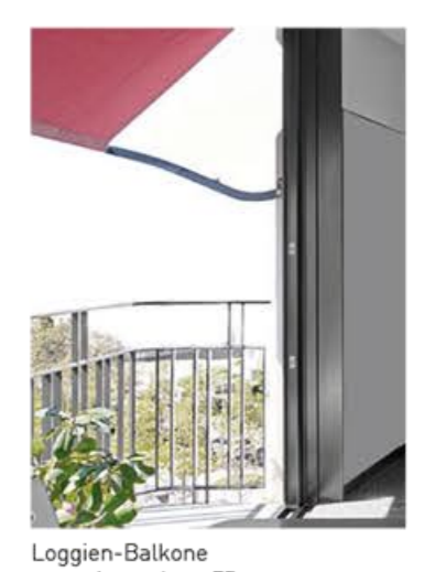
Loggen-Balkone vorgehängt um 75 cm vor die Fassade
