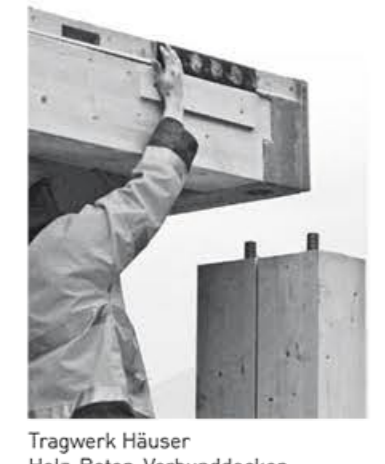
Tragwerk Häuser: Nicht-Beton-Verbindungen Stützen in Fassadenebene
